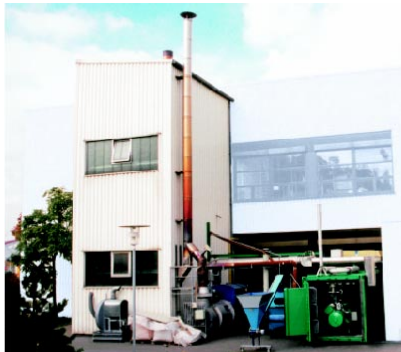
Bild 8: Pilotanlage bei Fraunhofer UMSICHT links: ZWS-Gaserzeugung; rechts (unten): BHKW (Container-Einheit)
